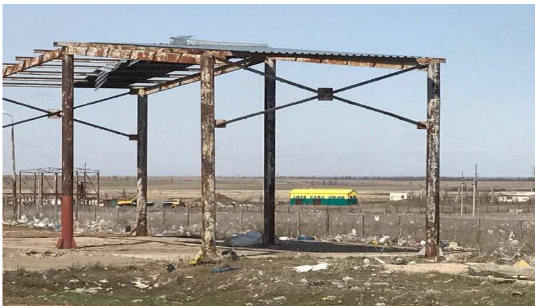
Рисунок 2 – Вид недостроенного мусороперерабатывающего завода на полигоне ТБО в г.Уральск
